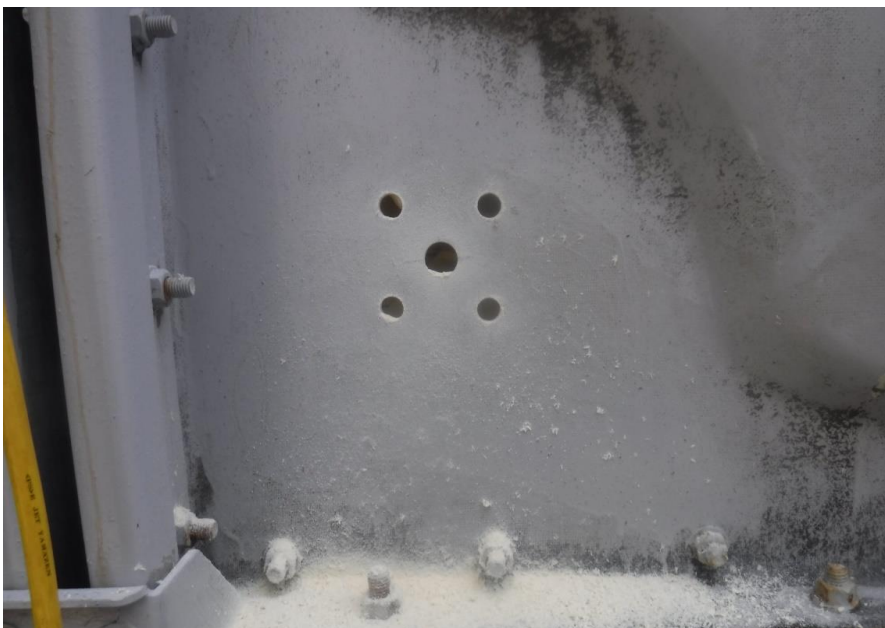
緊急用水栓取付工事中
