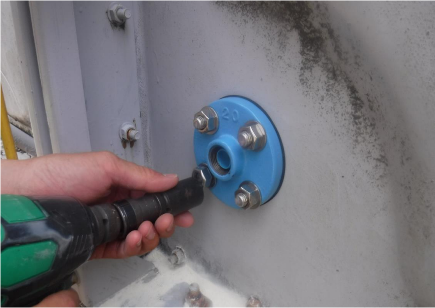
緊急用水栓取付工事中
