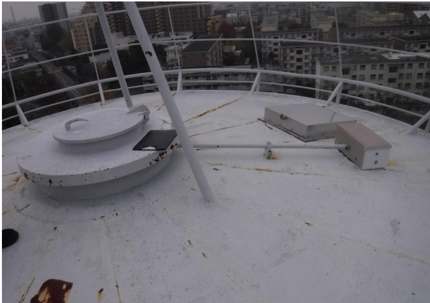
天井全面補修工事前
