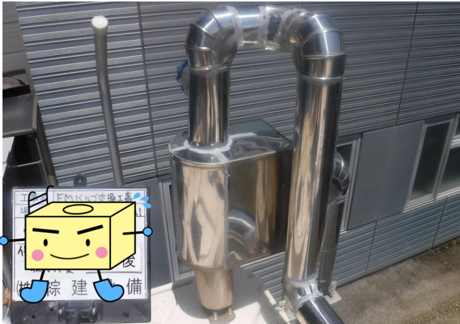
FMバルブ交換工事後
