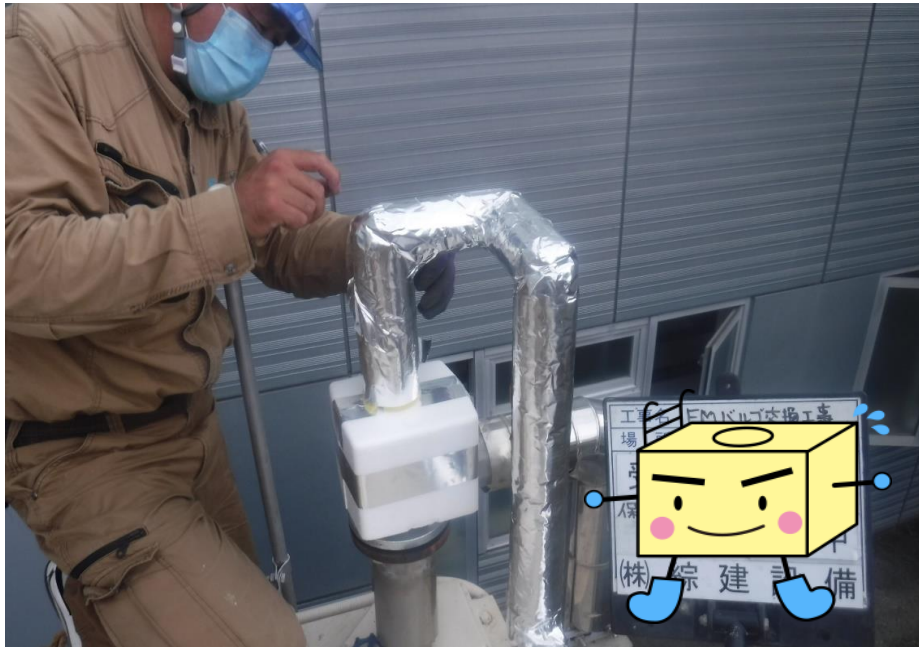
FMバルブ交換工事中 保温材取付け中
