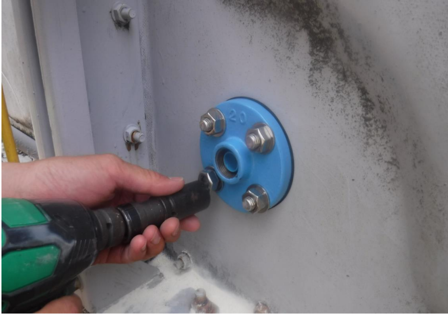
緊急用水栓取付工事中
