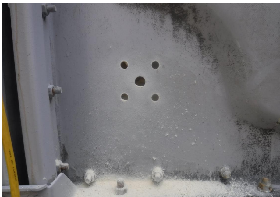
緊急用水栓取付工事中
