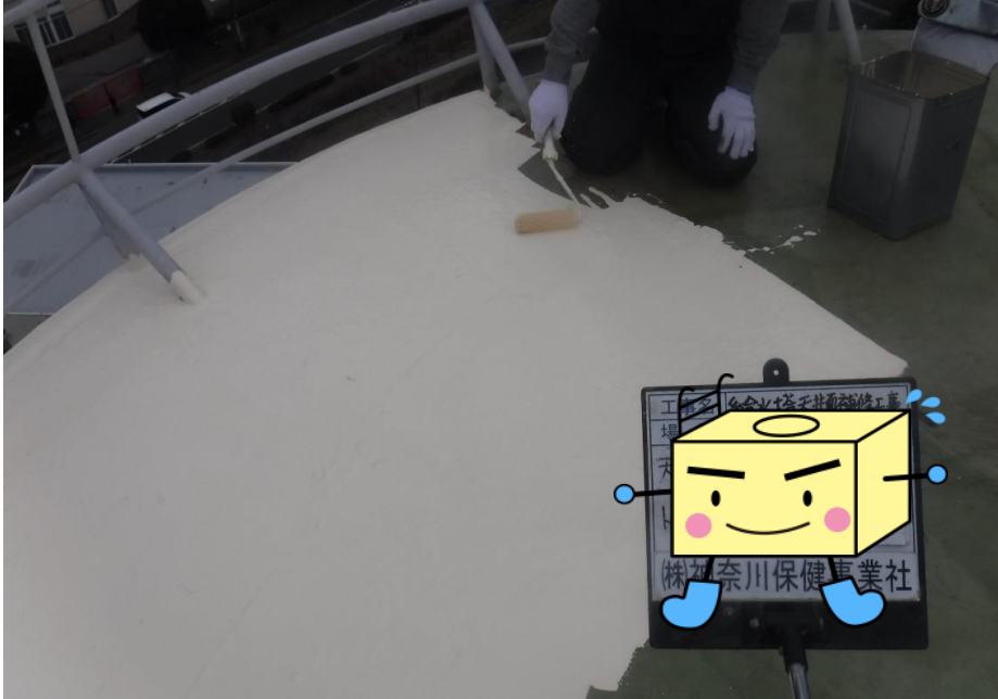
天井全面補修工事中
