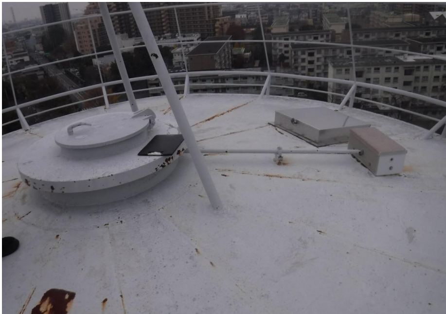
天井全面補修工事前 FRP積層
