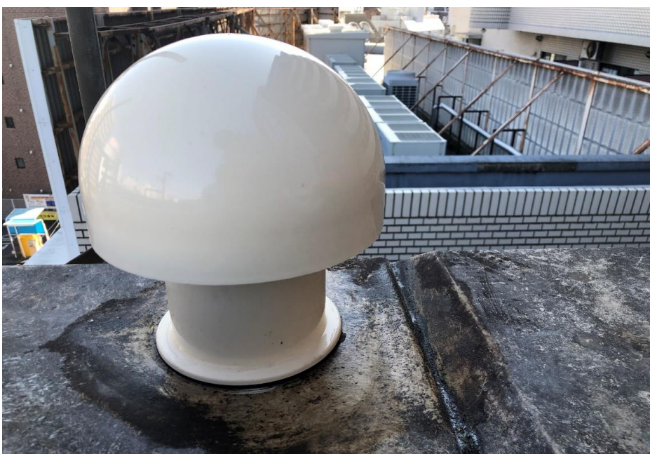
受水槽メンテナンス後
