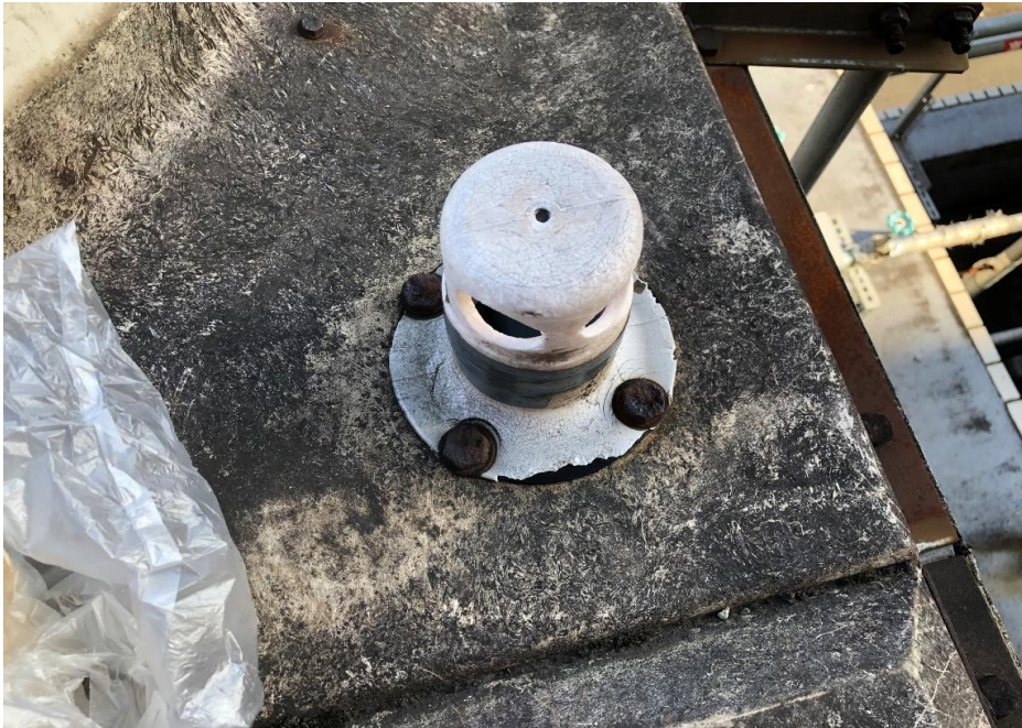
受水槽メンテナンス前
