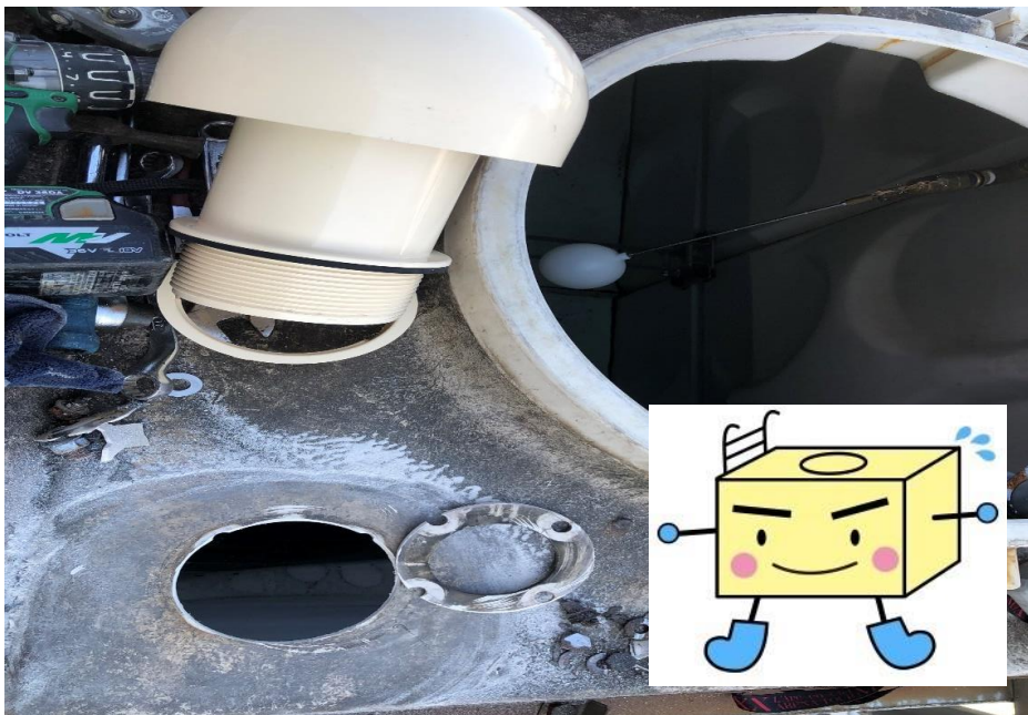
受水槽メンテナンス中
