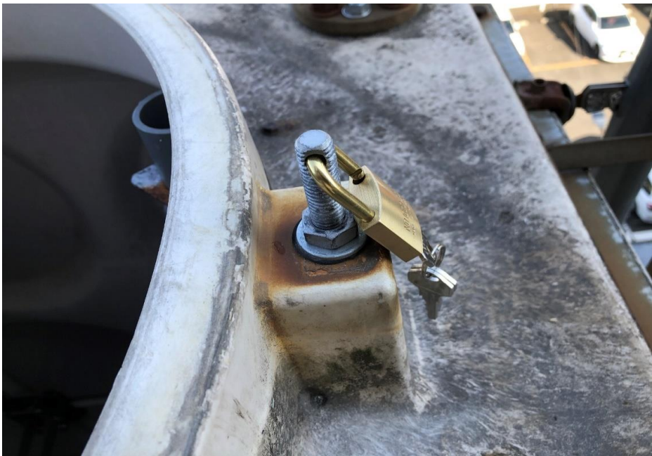
受水槽メンテナンス後
