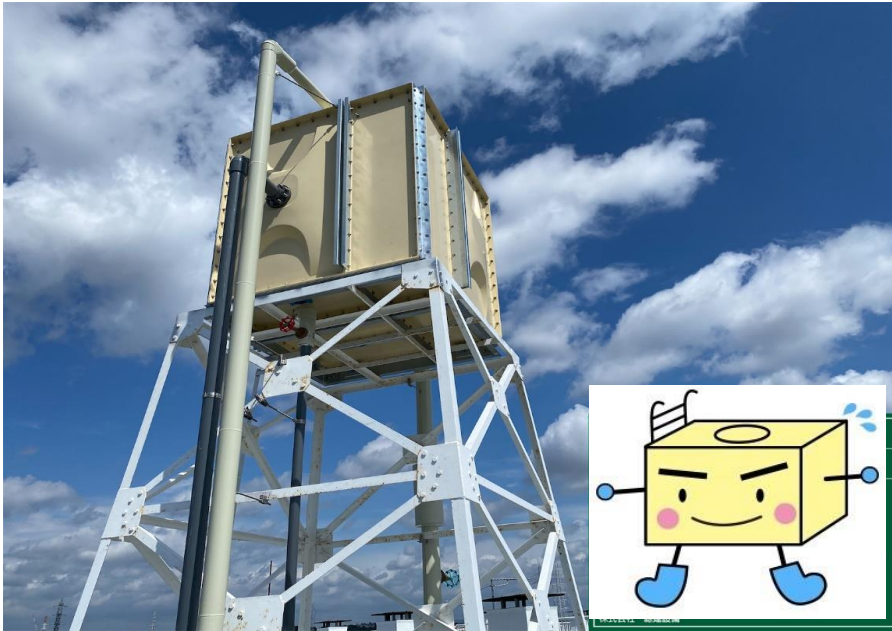
高架水槽更新工事後
